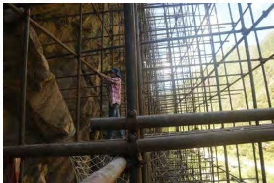
图二 勒巴沟吾娜桑嘎佛教石刻所在山体搭起脚手架的场景
