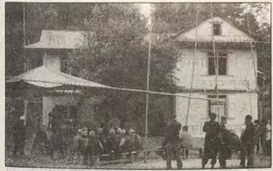
बाक्सलामा नवनिर्मित दु.कि.रा.फ.को भवन ।
